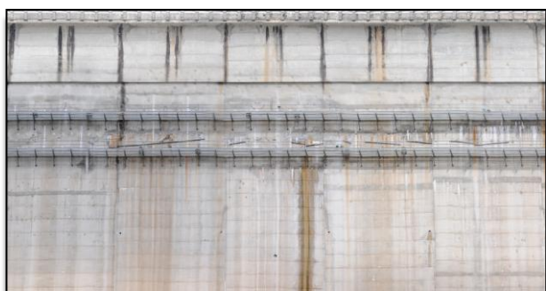
Figura 3 – Orto-imagem do paramento jusante da barragem do Cabril, com uma resolução de 1 centímetro
