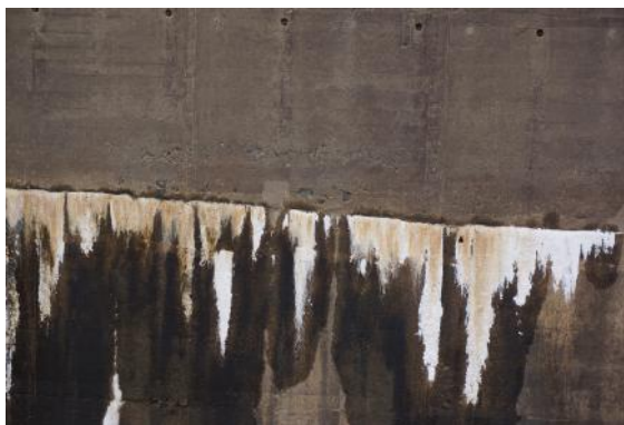
Figura 10 – Uma das fotos obtidas em frente ao paramento de jusante
