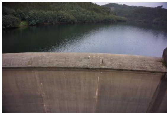
Figura 11 – Uma das fotos obtidas junto ao descarregador central
