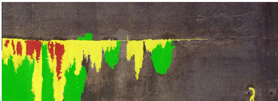
Figura 15 – Identificação automática de ocorrências por classificação orientada por objetos. Significado das cores: verde – betão molhado; amarelo – carbonato de cálcio com cor branca; vermelho – carbonato de cálcio com cor castanha
